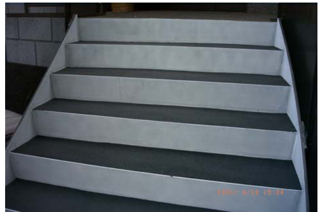
▲排水性階段踏面舗装
